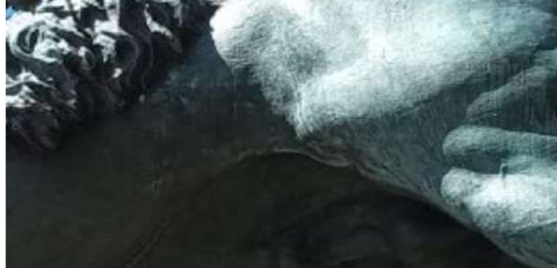
Figura 4: ossidazione del bronzo sulle aree dilavate
